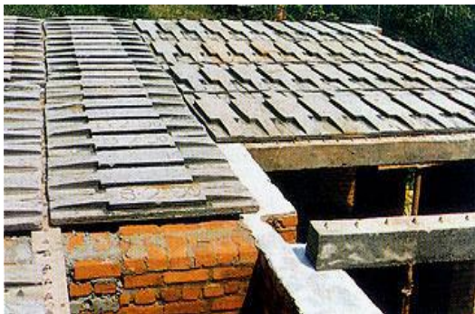
Fig. 2 Precast R.C. Planks
